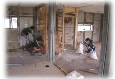
↑壁をはずしているところです。かなりの力が必要！
