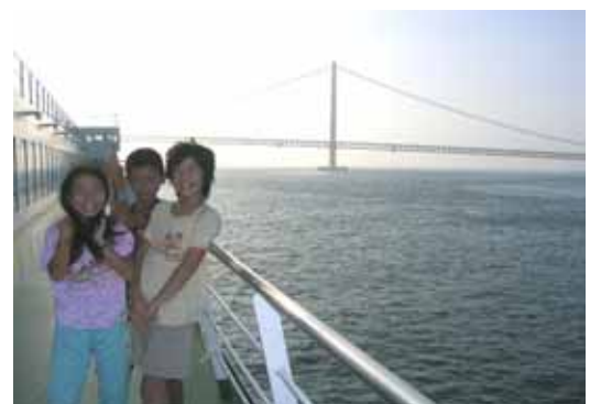
世界最長1991mの橋
